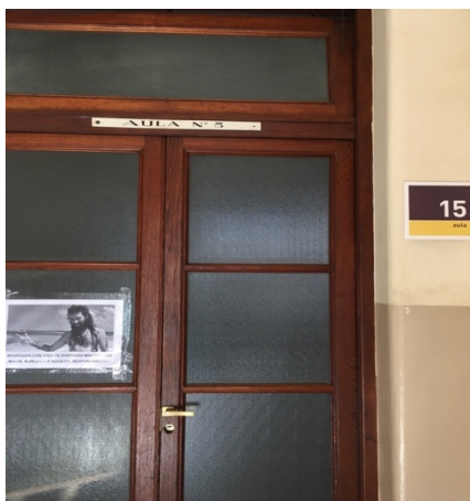
Ilustración 12- Puerta aula 15 - Fuente propia
