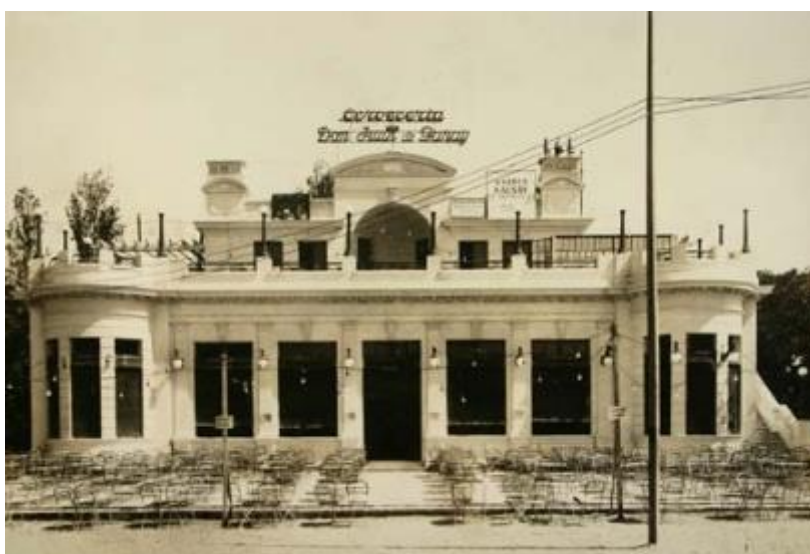
Figura 4 - Cervecería Don Juan de Garay (demolida)
