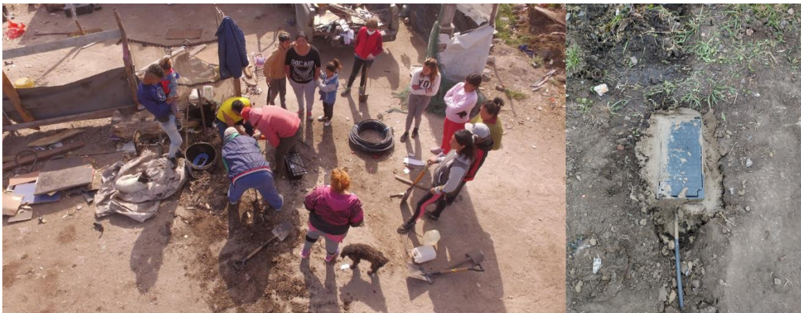
Imagen 12. Construcción de la red e instalación de cajas domiciliarias.
