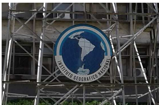
Vista del frente del edificio del IGN ubicado en Av. Cabildo 381, CABA.
