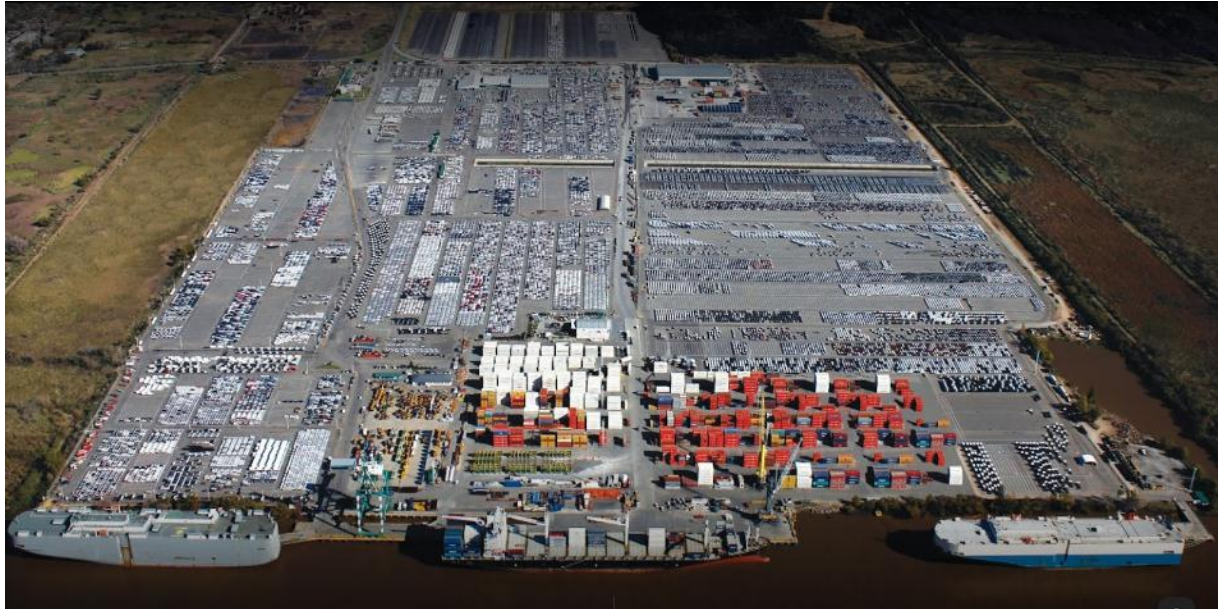
Figura N° 5 Terminal Portuaria “TZ”.
