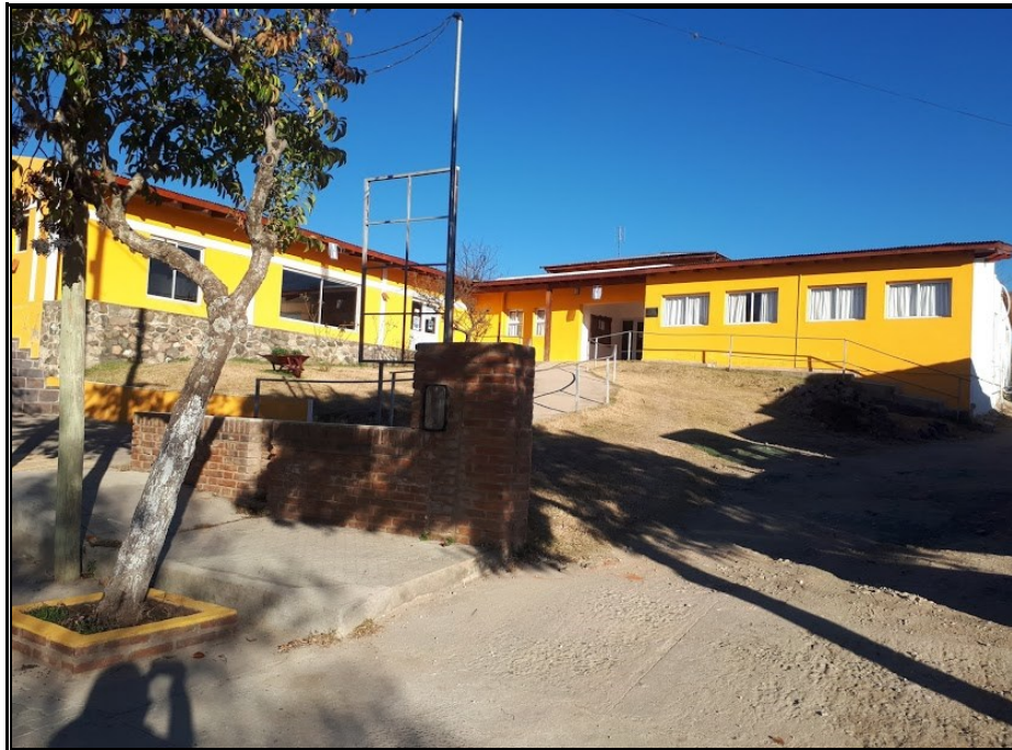
Fuente propia – Fotografía 11: Comuna La Serranita – Nuevas instalaciones
