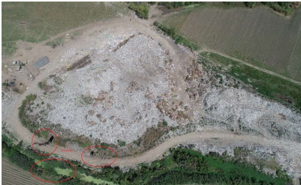
Figura 10. Derrame de lixiviados en el vertedero de Concepción [fotografía], Dirección de Medio Ambiente de Concepción. (2019). Modificado por Quinteros, R. (diciembre de 2020).
