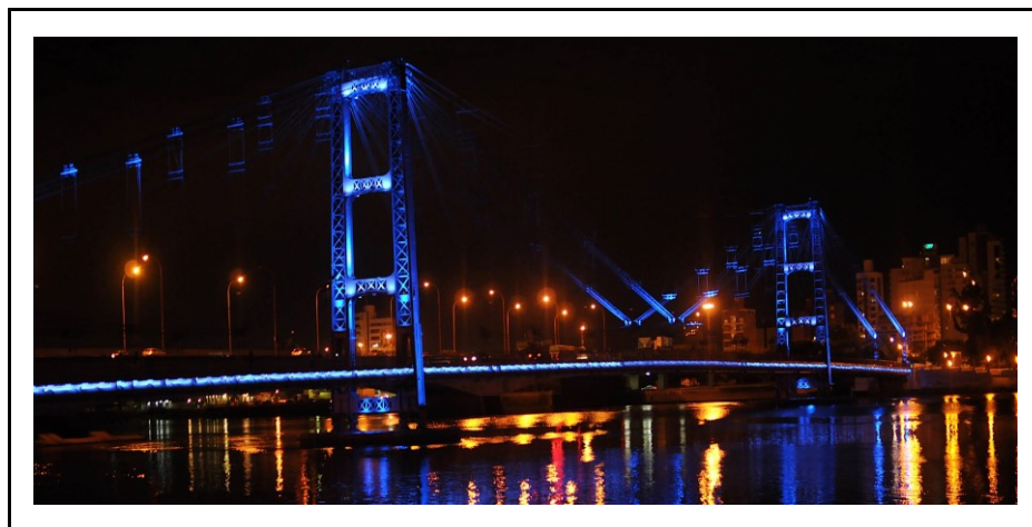
Figura 40 - Puente Colgante con iluminación LED.
