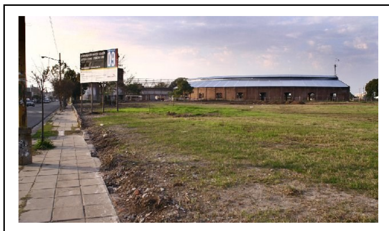
Figura 15 - Parque Federal deteriorado.
