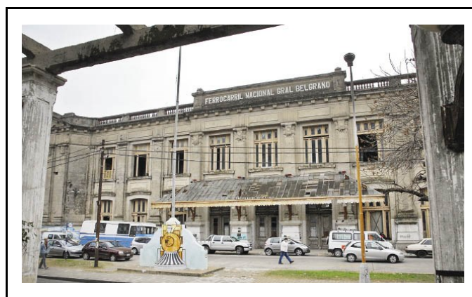
Figura 32 - Ex Estación Belgrano deteriorada.
