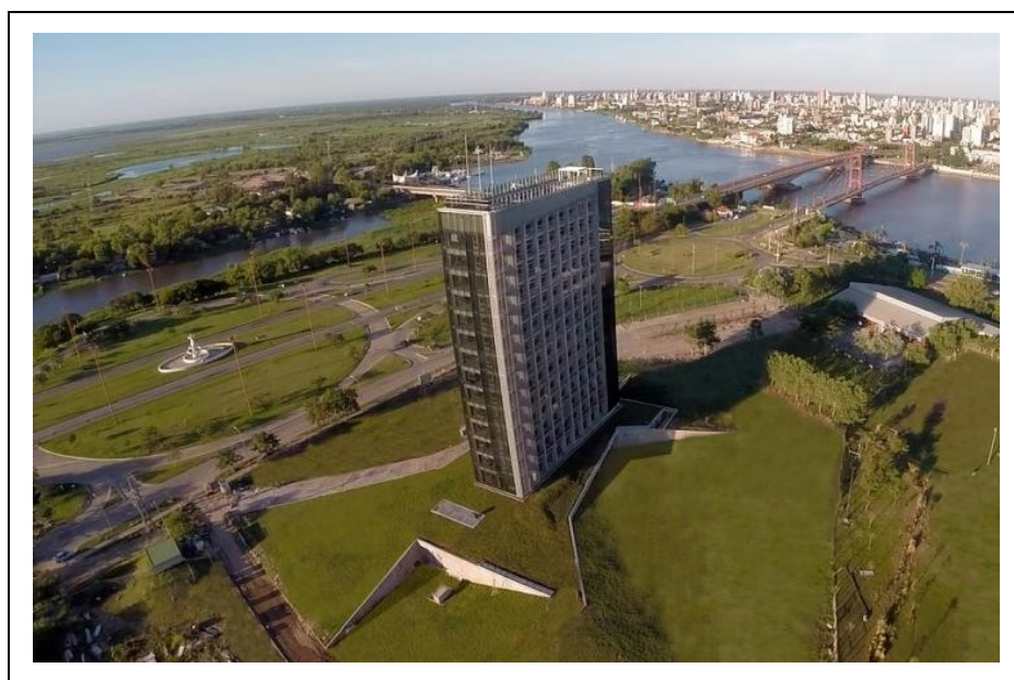
Figura 46 - Vista trasera Hotel UNL-ATE.
