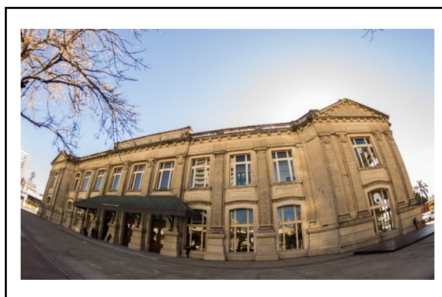
Figura 33 - Actual “Centro de Convenciones Estación Belgrano”.
