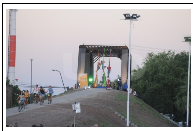
Figura 23 - Emblemático “Puente Negro” revalorizado como parte del Paseo Escalante.
