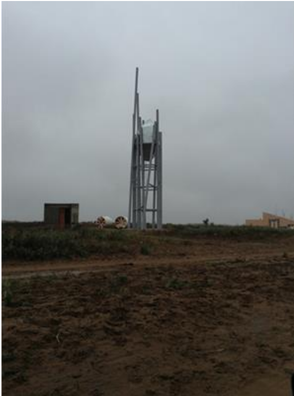
Figura 6. 3. Tanque de agua. Año 2014
