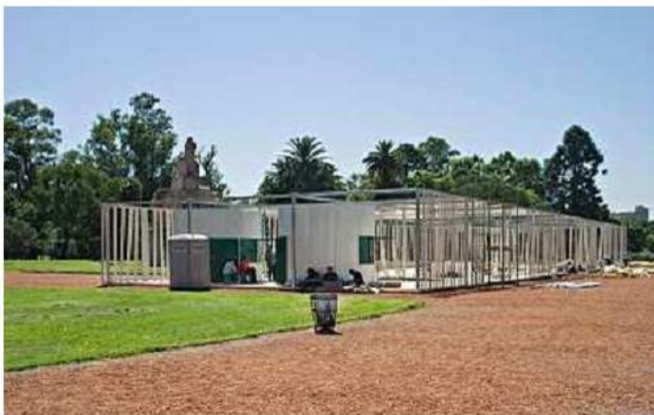
Figura 9.3: gazebos de chapas de cinc en uno de los extremos del Pabellón Argentino del Bicentenario. – Imagen: http://www.eternautasblog.com
