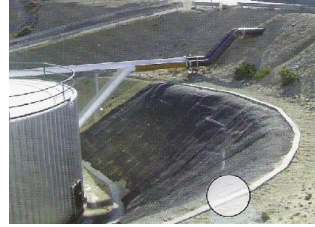
Talud con geomanta y malla.
