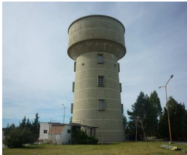
Figura 9: Tanque de almacenamiento de Monte Hermoso
