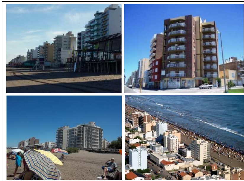
Figura 6: Edificios sobre Avenida Costanera
