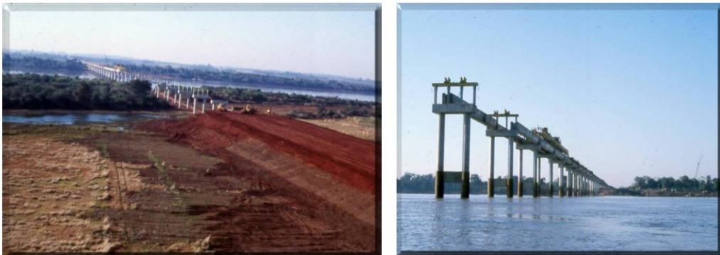
Fotografías N° 1 y 2: construcción del Puente de la Integración Santo Tomé- San Borja
