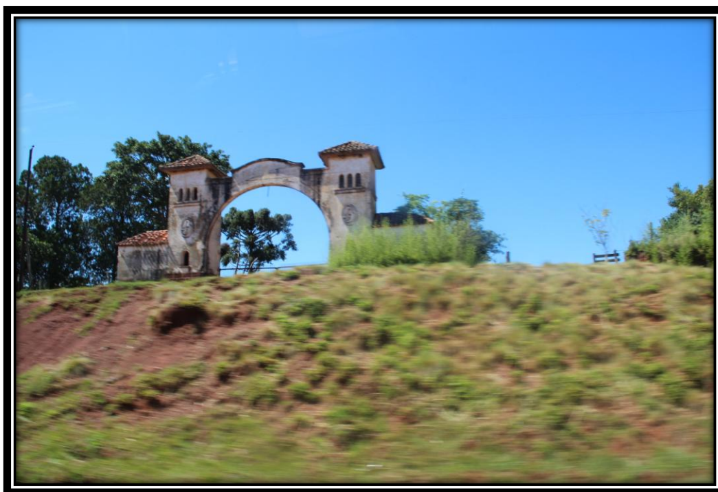
FOTO N° 4: Vista del acceso a la ex Tabacalera “43” desde la Ruta Costera 2.
