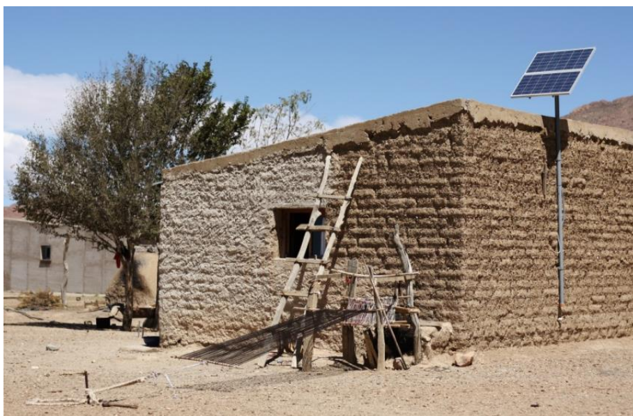
Equipos fotovoltaicos instalados, en una vivienda de la Puna Jujeña. (Registro propio)
