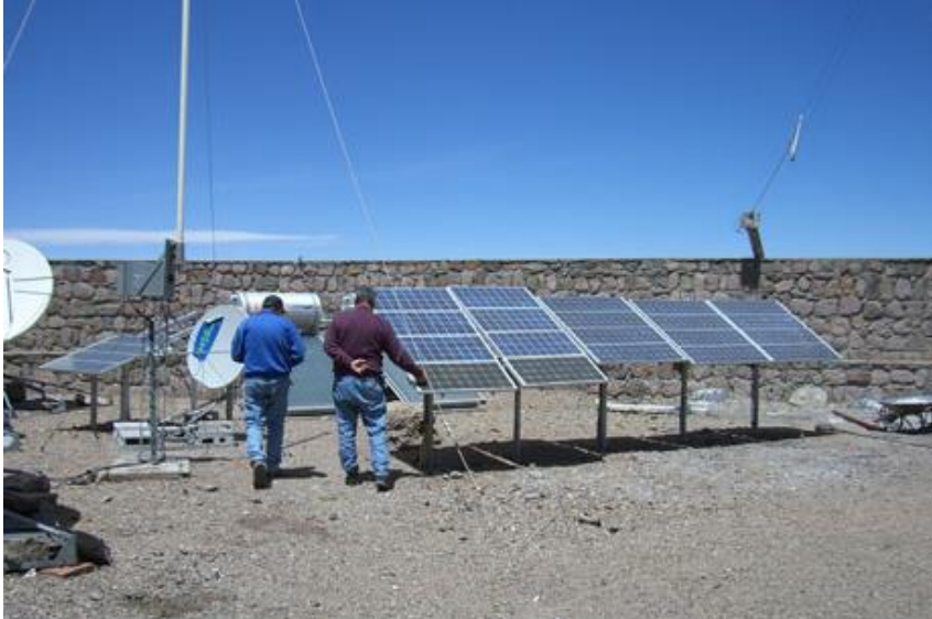
Central de generación solar, minired fotovoltaica en la provincia de Jujuy. (Fuente Secretaría de Energía de la Nación n.d.)
