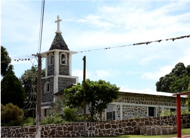
Extensión de las redes en San Francisco, Valle Grande. Registro propio.
