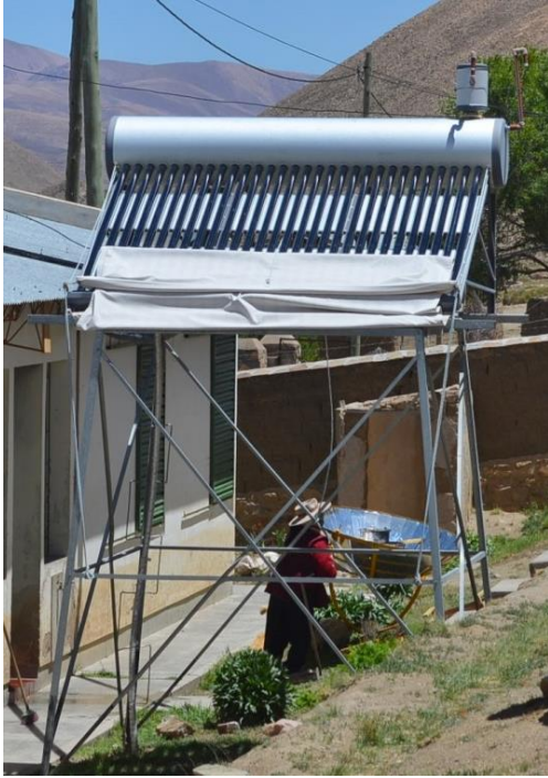
Termotanque solar de tubos al vacío, con Termotanque solar de placa plana. Instalación en cobertor. Instalación en escuela de Jujuy. (Registro propio).
