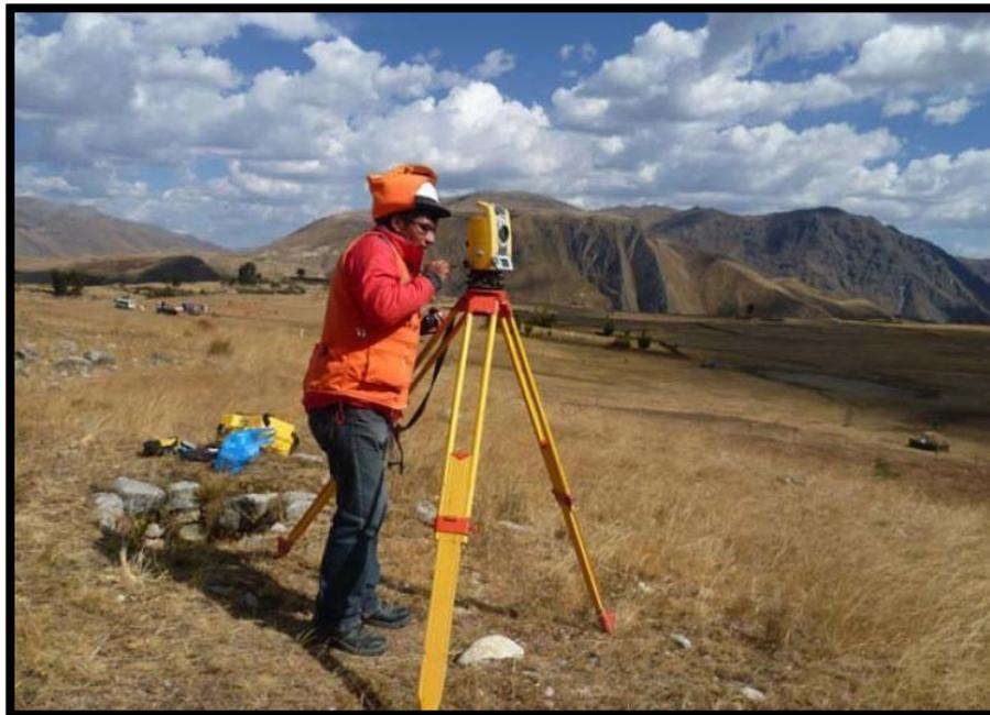
*Fotografía N°4 Replanteo Topográfico Fuente: Propia*
