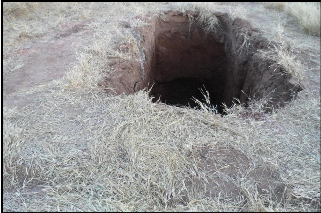
*Fotografía N° 8 Excavación para Fundación Fuente Propia*
