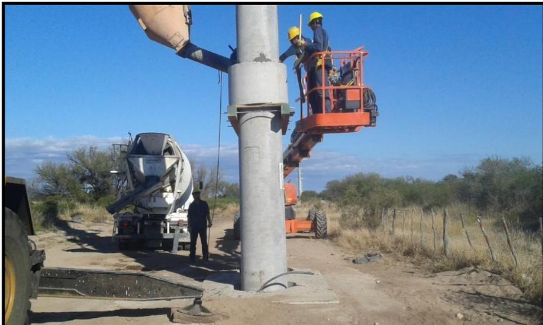
Fotografía N° 10 "Armado de Estructuras Doble"
