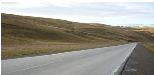
Figura 22 Reptación de laderas en la margen izquierda del Río Turbio.
