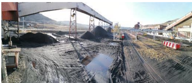
Figura 17 Planta depuradora zona de acopio de minerales depurado.
