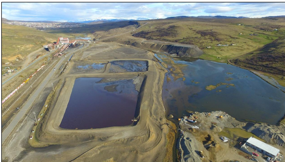
Fig. 5 Taludes de estériles.
