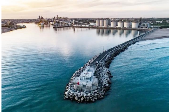
Figura N°32: Mirador Escollera Norte sobre el Río Quequén 8 .
