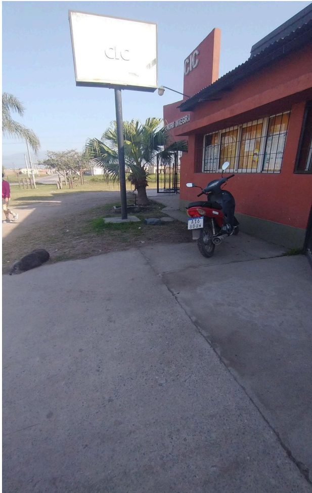
Puerta de entrada del personal de salud del CIC Los Jacarandás San Miguel de Tucumán Foto propia - Año 2023
