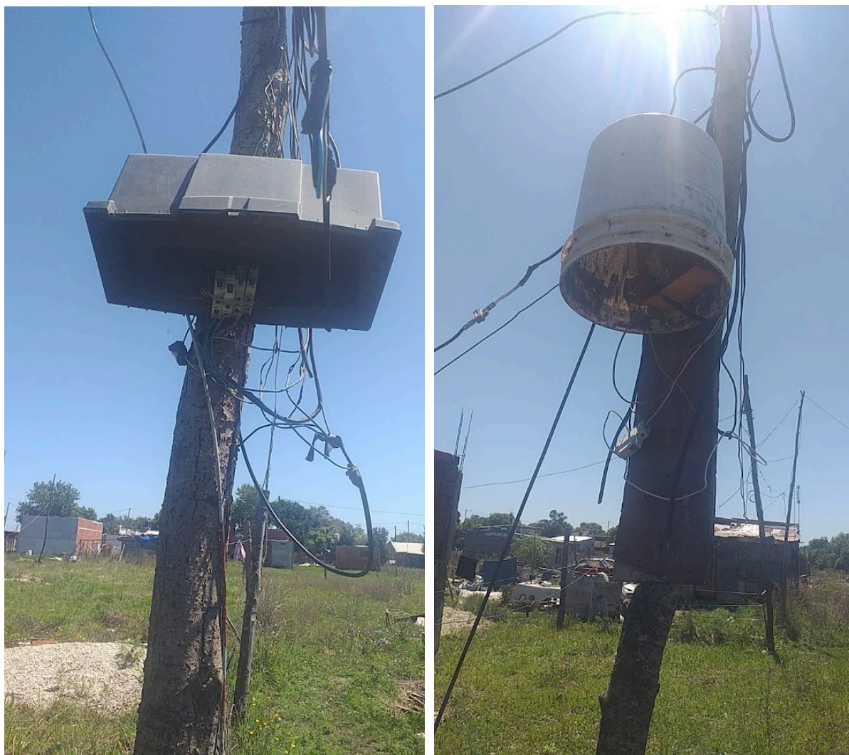
Figura 9. Fotografías de conexiones irregulares comunitarias Barrio caribe calle Wilde entre Avellaneda y Arroyo.
