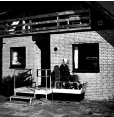
Plataforma vertical, salva de hasta un metro de altura
