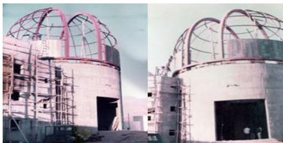
*Ilustración 11. Estado de la cúpula, albergue del telescopio de 2,15 m en 1983 (Fotografía del autor)<sup>76</sup>*
