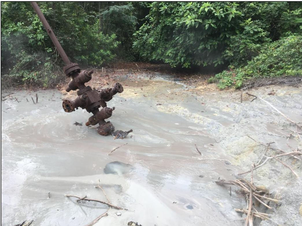
*Foto 3: Cabeza de pozo caída y desplazada - Pozo YPF.Jj.CA.E-3*
