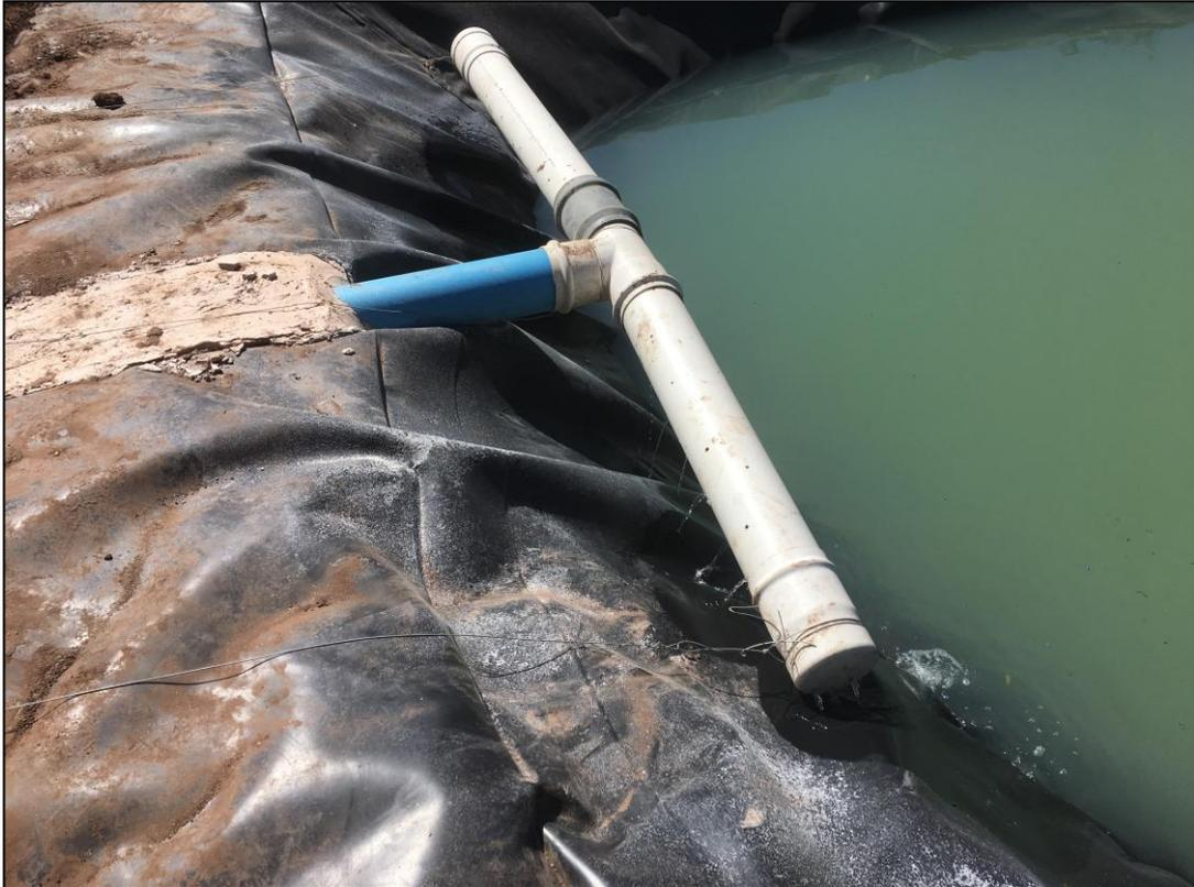
*Foto 18: Cañería reductora de velocidad*
