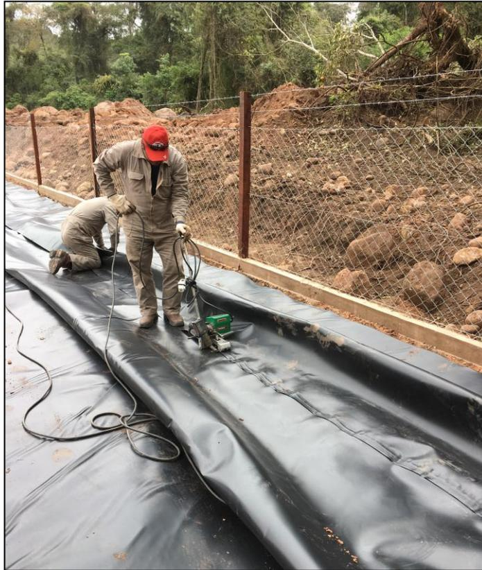
*Foto 13: Colocación de membrana HDPE*
