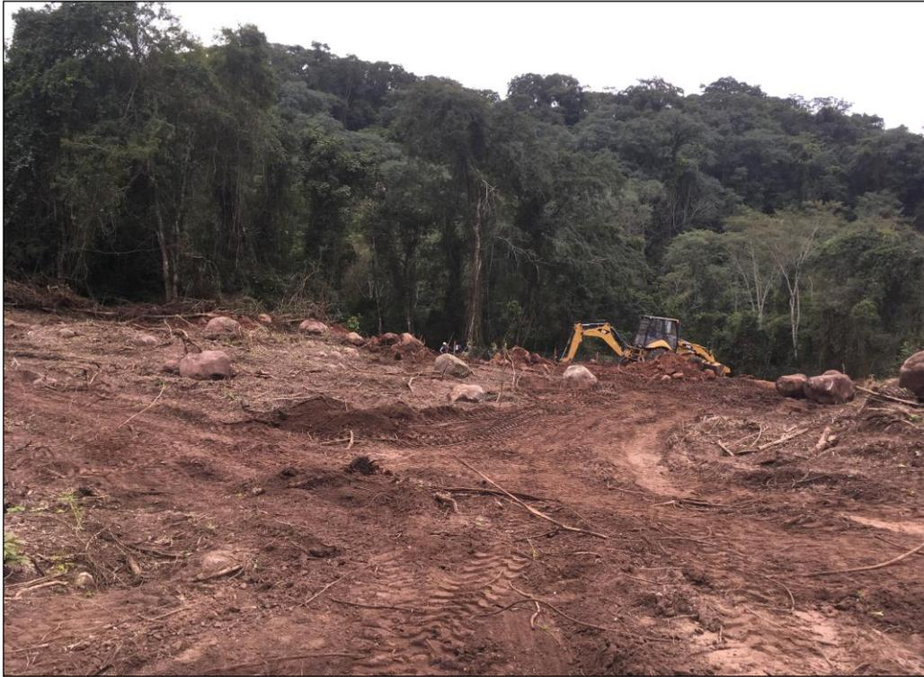
*Foto 8: Apertura de la planchada de la represa*
