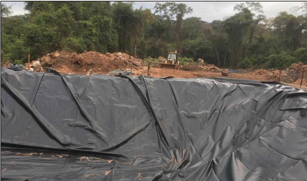
*Foto 12: Colocación de membrana HDPE*
