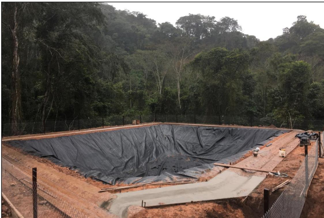
*Foto 14: Represa recubierta con membrana de HDPE*
