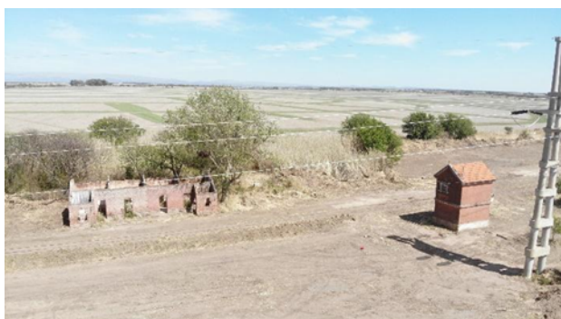
Imagen N.º 6.25: Parador ferroviario Km. 784 y cabina de señales. Sinsacate Estado de conservación: Ruinas/Abandonado Fotografía del Autor – Fecha de toma: 22 de noviembre de 2022
