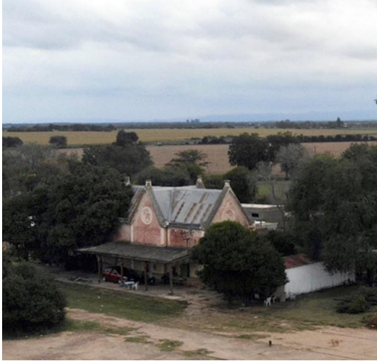
Imagen N.º 6.2: Estación ferroviaria General Paz. Estado de conservación: Malo. Fotografía del Autor. Fecha de toma: 24 de abril de 2023
