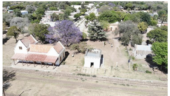
Imagen N.º 6.31: Vista aérea de Estación Sarmiento y casa del guarda.
