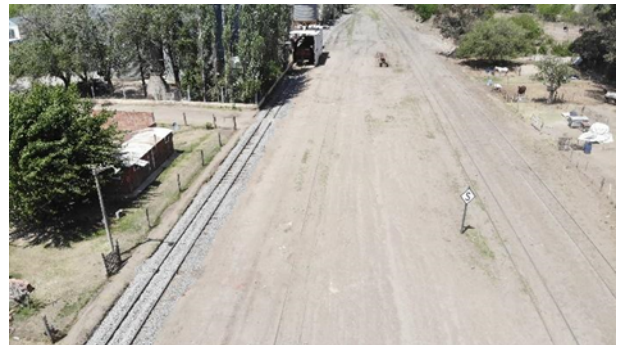
Imagen N.º 6.9: Líneas ferroviarias de Estación Caroya Estado de conservación: 2 líneas en estado de abandono. 1 línea en estado de renovación Fotografía del Autor – Fecha de toma: 22 de noviembre de 2022
