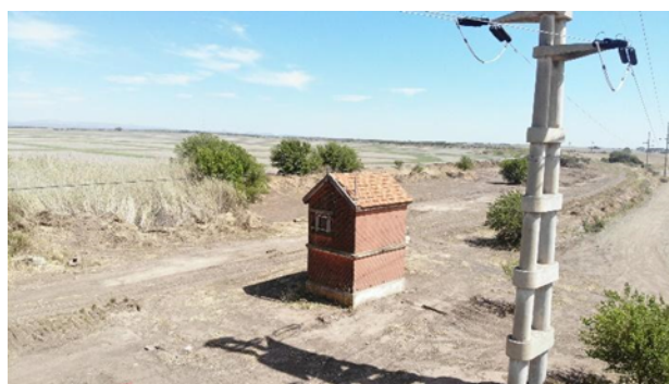
Imagen N.º 6.24: Cabina de señales, vista trasera. Parador ferroviario Km. 784. Sinsacate Estado de conservación: Malo/Abandonado Fotografía del Autor – Fecha de toma: 22 de noviembre de 2022
