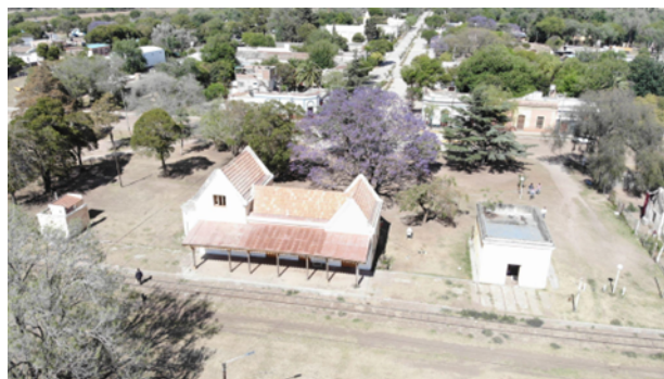
Imagen N.º 8.16: Estación Sarmiento – Fuente: Fotografía del autor
