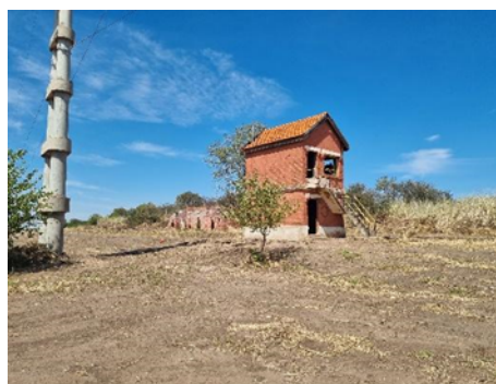
Imagen N.º 6.26: Cabaña de señales, vista frontal. Parador ferroviario Km. 784. Sinsacate Estado de conservación: Malo/Abandonado Fotografía del Autor – Fecha de toma: 22 de noviembre de 2022
