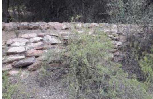
Haciendo referencia a una galería filtrante, una construcción que permite la captación de agua y que es común de hallar en la zona por ser ríos que arrastran material rocoso de dimensiones variables que pueden generar obstrucciones en los canales.
