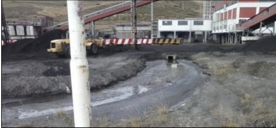
Fig. 13 - Lugar de descarga de material en suspensión de Planta Depuradora
