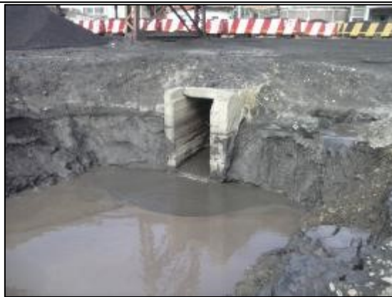
Fig. 14 Detalle de descarga de efluentes con alta carga de materiales en suspensión
