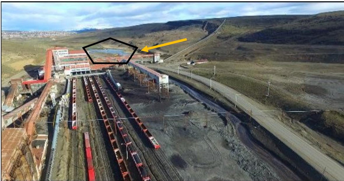
Fig. 8 Zona Industrial Planta Depuradora, en el polígono se observa la ubicación de presencia de animales. Fuente: Elaboración propia por medio de dron. (2017).
