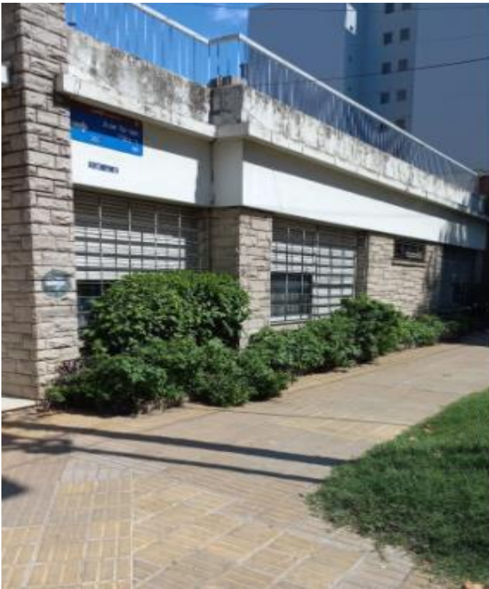
Edificio sin canteros en vereda ni árboles.
