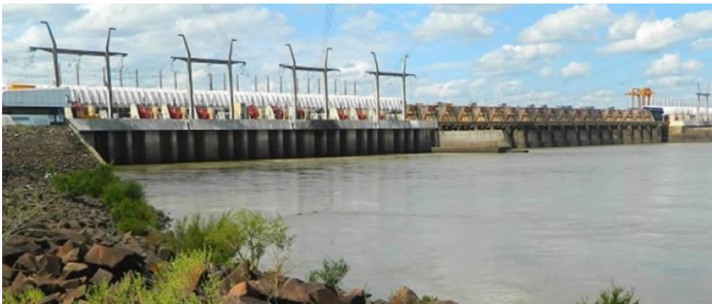
Imagen N°8: Complejo Hidroeléctrico Salto Grande.
