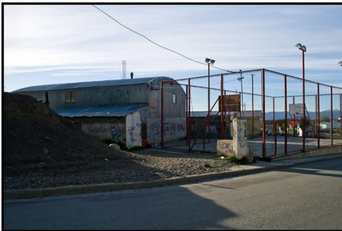
Imagen N°1: Obrador abandonado y ocupado por vecinas/os, principios de 2000.
