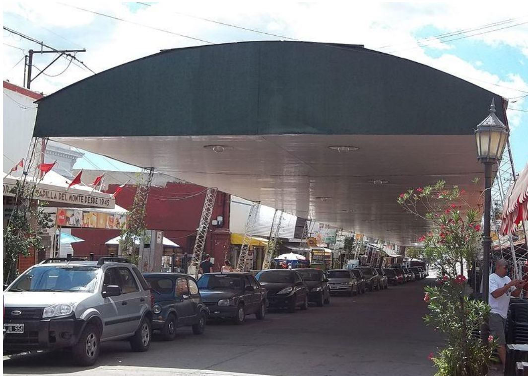
4-n. La ya histórica Calle Techada, única en Sudamérica, Capilla del Monte. Foto año 2015
