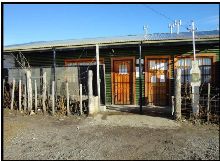
Imagen 5: revestimiento exterior en chapa.
