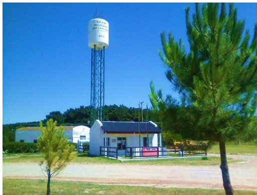
Figura N° 65 Instalaciones de Agua Potable
