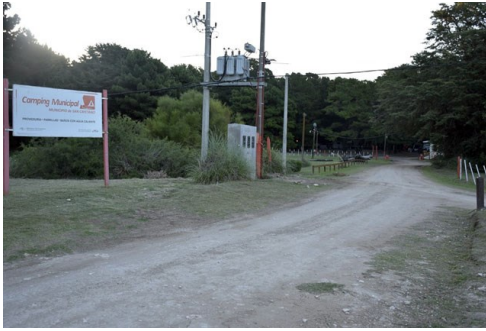
Figura N° 76: Entrada al camping Municipal Archivo propio (2020)
