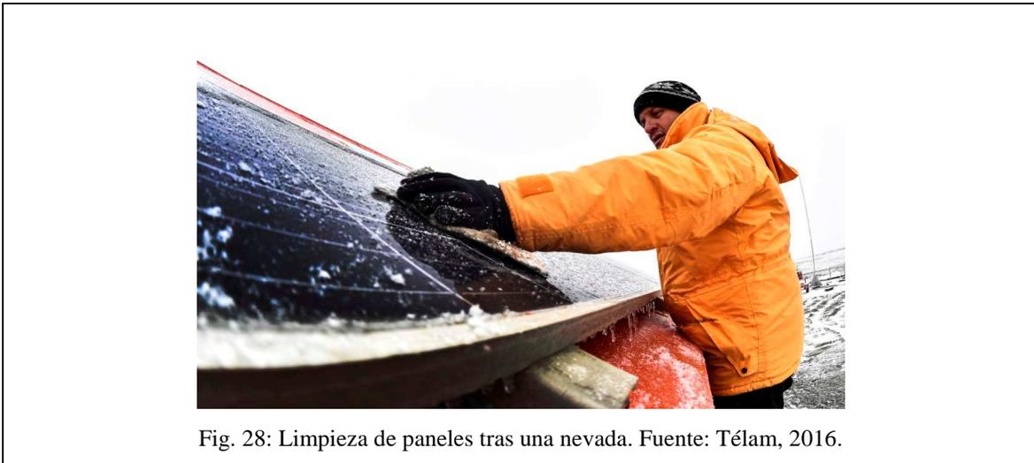
Fig. 28: Limpieza de paneles tras una nevada. Fuente: Télam, 2016.
