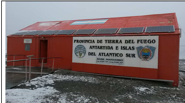
Fig. 26: Paneles FV en la Terminal de Pasajeros de Base Marambio. Fuente: Autor, 2016.
