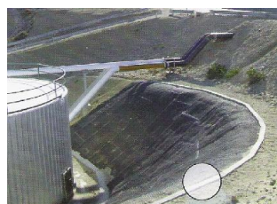
Talud con geomanta y malla.
