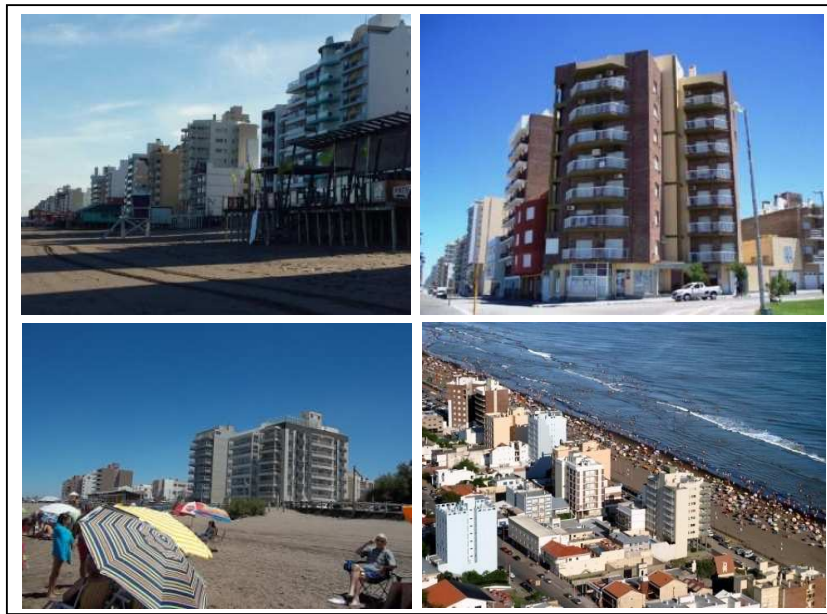
Figura 6: Edificios sobre Avenida Costanera
