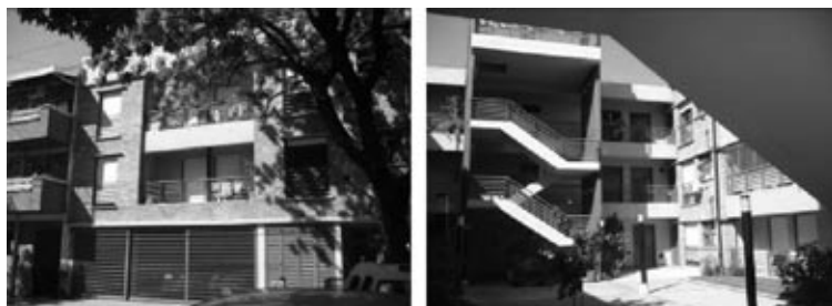
Figura 4. Alternativa IV. Viviendas autoconstruidas. Estomba 1167. Edificio habitado, sin finalización de obra
