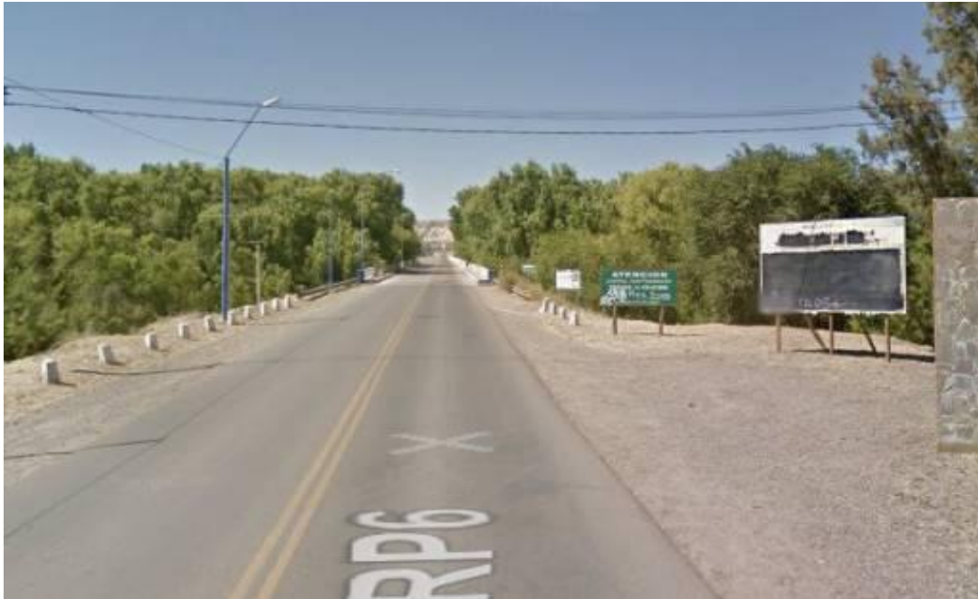
Foto I. Puente Paso Córdoba
