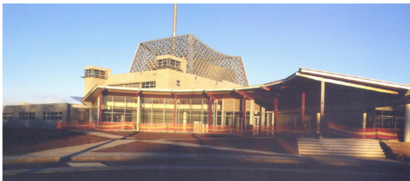
Figura 3. Edificio del reactor OPAL (Australia)
