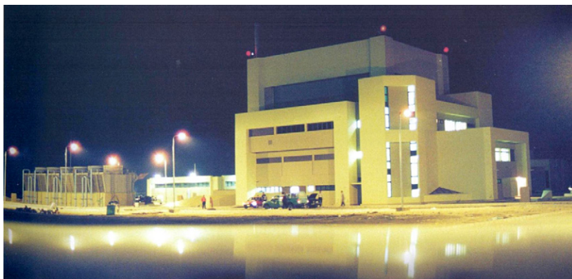
Figura 2. Edificio del reactor ETRR-2 (Egipto)
