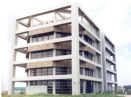
Figura 1. Edificio del reactor NUR (Argelia)
