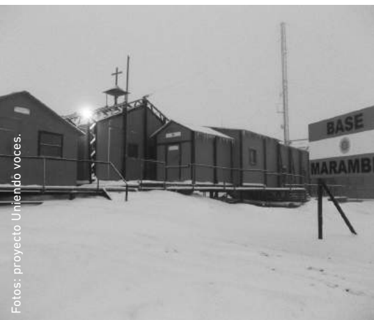
Imagen 13. Ingreso principal al alojamiento de Base Marambio.
