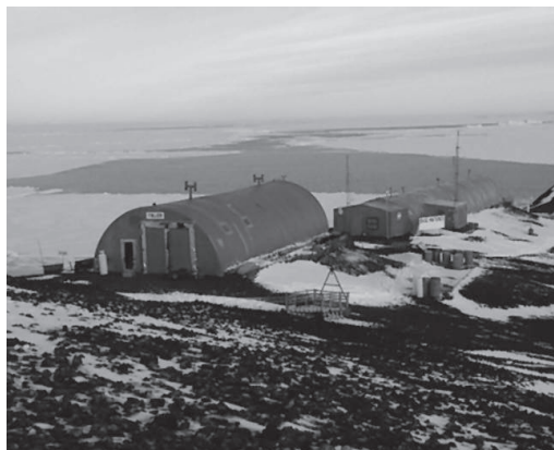
Imagen 18. Dos instalaciones de la base: usina-taller y casa alojamiento.
