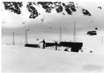
Orcadas, 1961. Torres y antenas de radio (Gentileza F. Gurzi).
