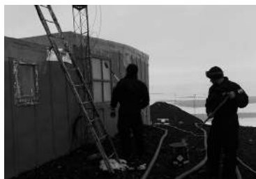
Trabajos de mantenimiento.
