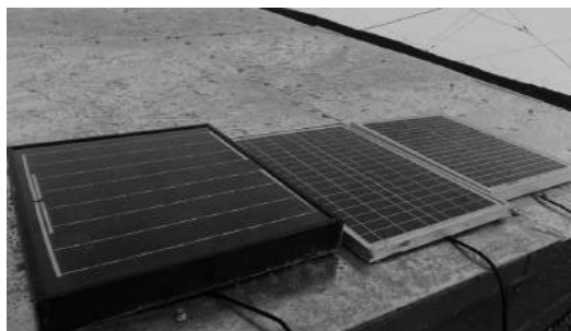
Paneles solares usados por UV.
