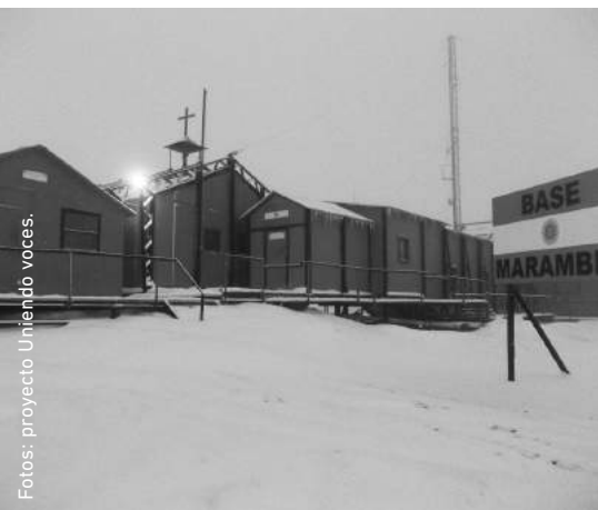
Imagen 13. Ingreso principal al alojamiento de Base Marambio.
