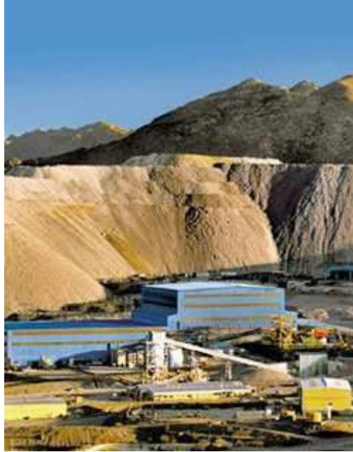
Imagen 4: Mina La Alumbraera. Escombreras (al fondo de la imagen) Fuente: http://www.alumbraera.com.ar/inst-beneficios.asp
