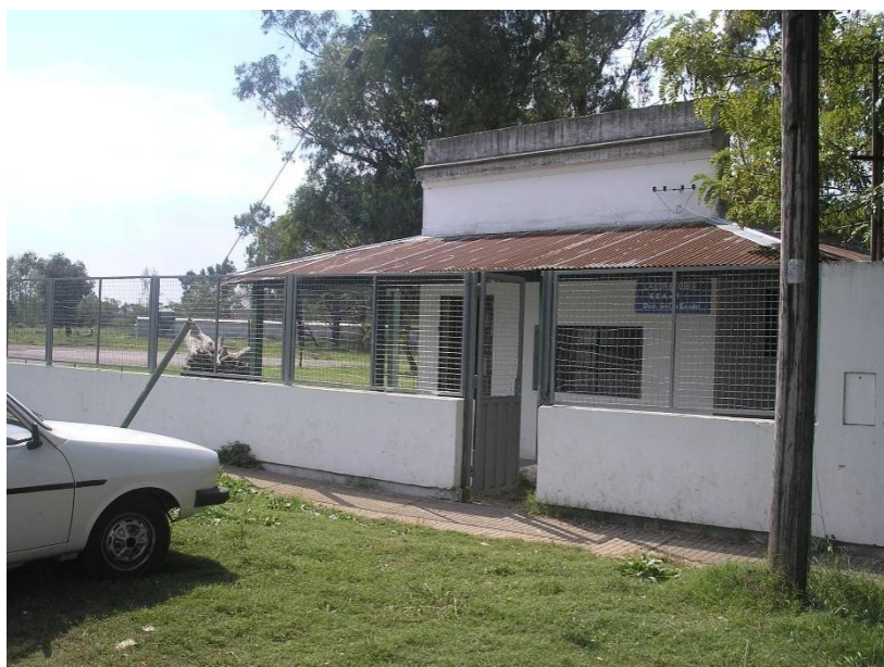
Imagen 7.7. Escuela Agropecuaria N.º 1, ex sede de la administración de la “Colonia La Capilla”, en la actualidad
