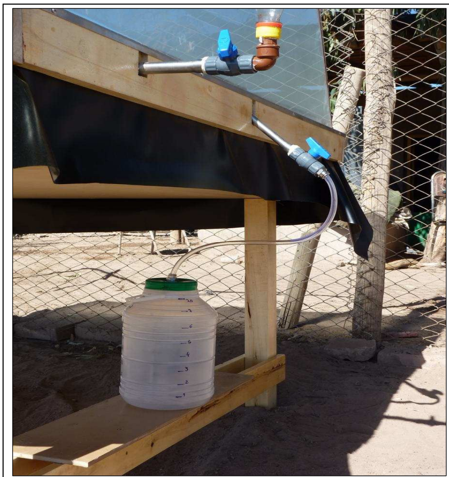
Imagen N° 13: El nuevo sistema de recolección y almacenaje de agua destilada permitió reducir la presencia de patógenos provocada por la manipulación.
