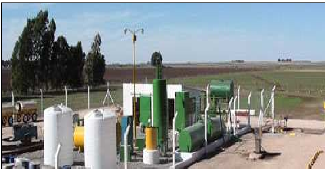
Imagen N° 21: Con el subsidio otorgado por el ministerio de asuntos agrarios y producción de la provincia de Buenos Aires se reformó la planta incorporando un área de laboratorio.
