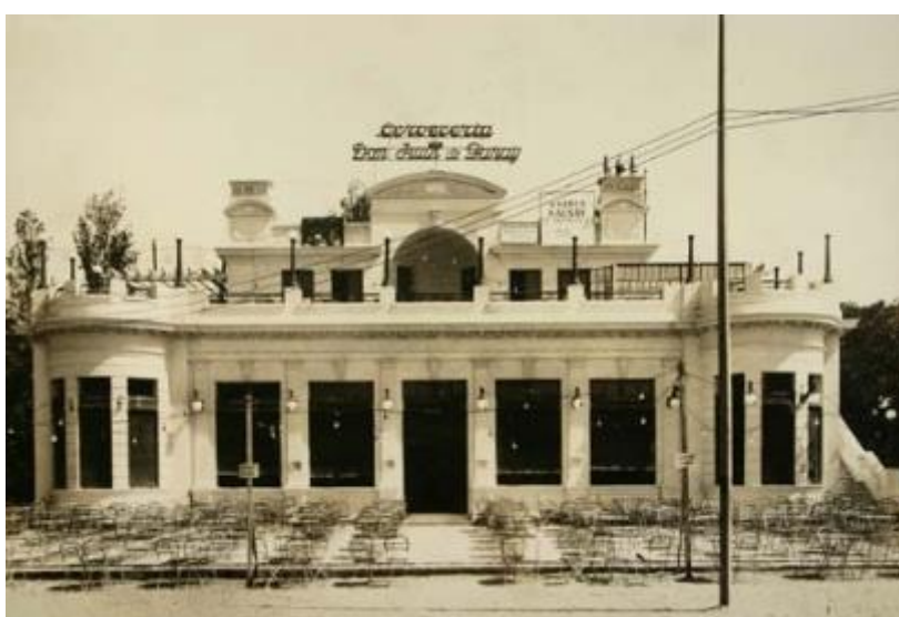
Figura 4 - Cervecería Don Juan de Garay (demolida)
